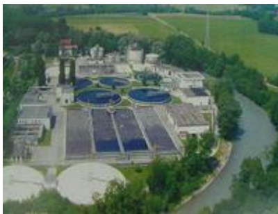
Impianto di depurazione e riuso SMAT Società Metropolitana Acque Torino a Collegno (TO)
